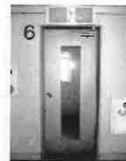
共用廊下からの見通しが確保されている階段室
