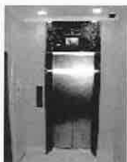
常時照明で明るく照らされ、防犯カメラが設置されたエレベーターホール
