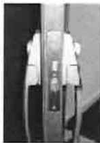
防犯格仕様の玄関扉 (扉の外装パネルが少し伸び、鍵と郵便口の隙間を隠す)
