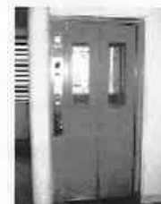
かご内を見通すことができる構造の窓が設置された扉
