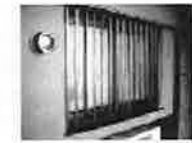
共用廊下に向した縦高窓の面格子
