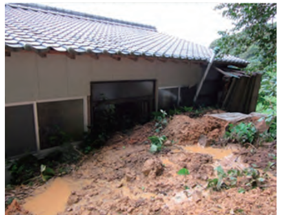
人家裏の斜面が崩壊 (平成29年 五島市)
