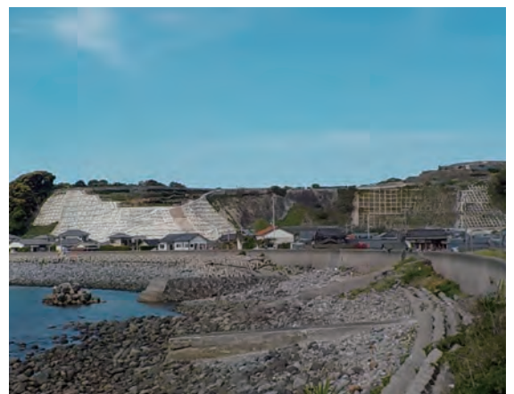
斜面下部の多くの人家を保全している法面工(雲仙市)
