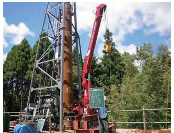
地すべりを止めるため地中に杭を打込む工事
