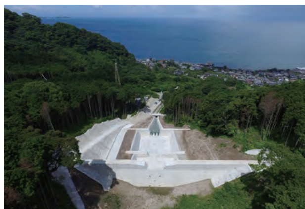
人家、道路を保全している砂防堰堤(雲仙市)
