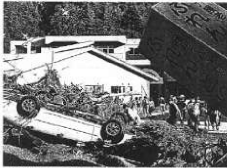
台風10号の大雨の影響で川が氾濫し、大きな被害を受けた岩手県岩手郡の高齢者施設。入所者とみられる9人が犠牲になった —31日午後4時27分
