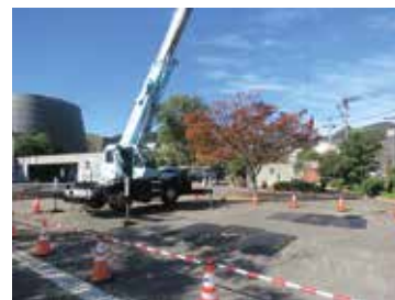
クレーン車体験
