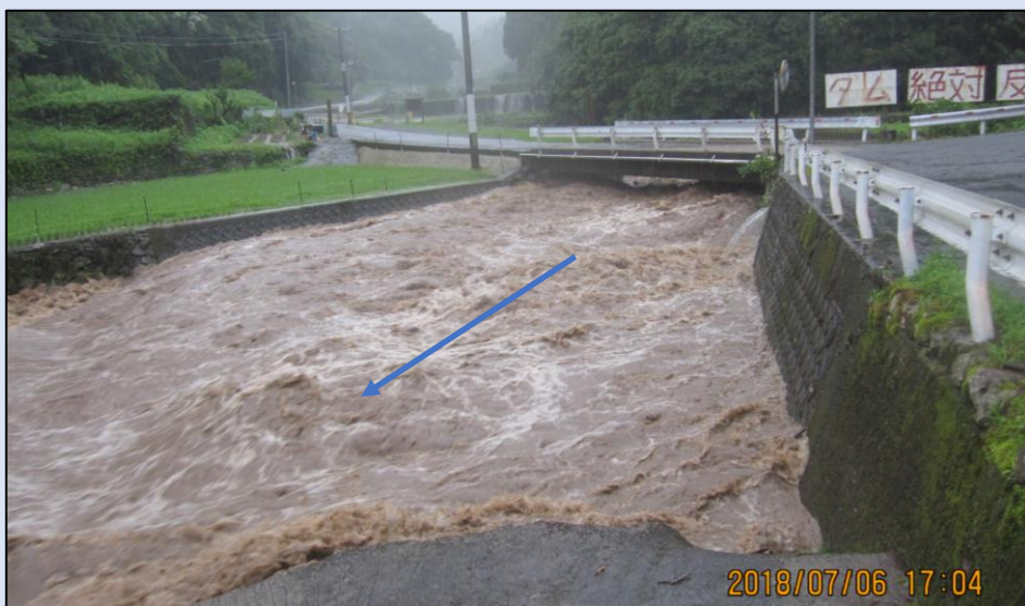
写真-1 平成30年7月6日 石木川 木場橋写真
