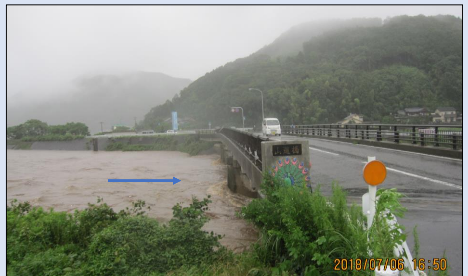
写真-2 平成30年7月6日 川棚川 山道橋写真
