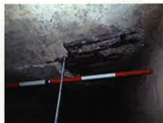
写真① ボックス内部状況
