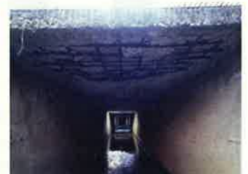
写真② ボックス内部状況
