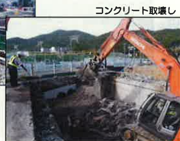
コンクリート取壊し
