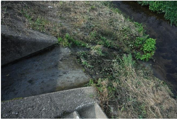
図9 地点7-3(第13号樋門)
