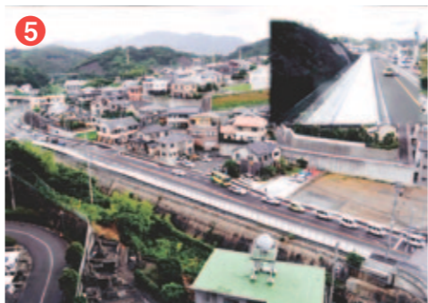
5 工事名 高田南高田線道路改築工事(2工区) 施工者/技術者 錦建設工業(株)/谷崎 和雄 工事内容 県道に歩道を整備する工事です。
