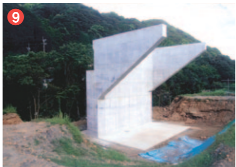
9 工事名 主要地方道佐世保吉井松浦線 橋梁整備工事(福井川橋A1) 施工者/技術者 (株)朽原建設/津田 賢一 工事内容 橋の橋台を新設する工事です。
