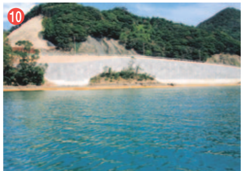
10 工事名 一般国道384号道路改良工事 (橋ノ木9工区) 施工者/技術者 (株)浜田組/宇野 晴海 工事内容 道路を拡幅するための工事です。
