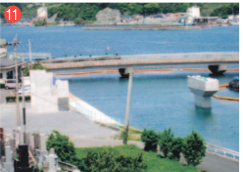
11 工事名 一般国道384号道路改良工事 (仮称)新相河橋A1・P1) 施工者/技術者 (株)坂本組/土井 徳幸 工事内容 橋の橋台、橋脚を新設する工事です。
