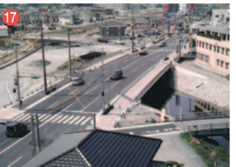
17 工事名 日野川河川改修工事(牽牛崎橋上部工) 施工者/技術者 (株)大島造船所長崎営業所/坪石 敏行 工事内容 橋の桁をかける工事です。
