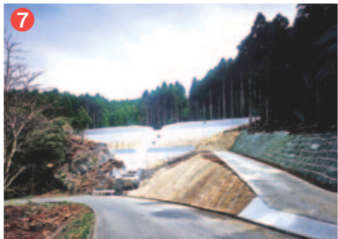
7 工事名 大山地区奥地保安林保全緊急対策工事 施工者/技術者 高瀬建設(株)/荒石 正三 工事内容 保安林機能保全のための工事です。
