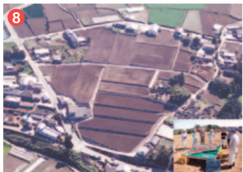
8 工事名 八斗木地区区画整理工事(2-1工区) 施工者/技術者 (有)武田建設/武田 健二 工事内容 農作業の効率化、収穫量向上のための工事です。
