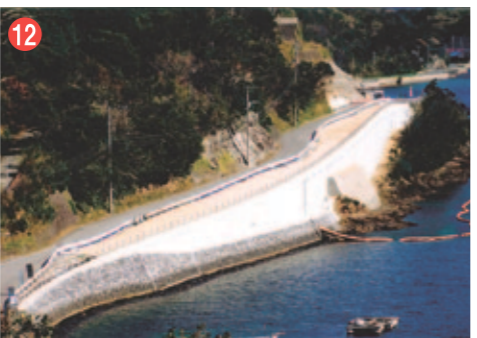
12 工事名 一般県道河務福江線道路改良工事(擁壁工) 施工者/技術者 (株)才津組/後川 洋 工事内容 道路を拡幅するための工事です。
