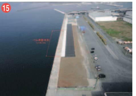
15 工事名 長崎地区水産流通基盤整備工事 (京泊地区岸壁改良) 施工者/技術者 門田・西部工建JV/濱本 三喜 工事内容 地震対策で護岸を補強する工事です。
