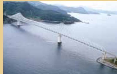
▲生月大橋(維持管理と振動対策)
