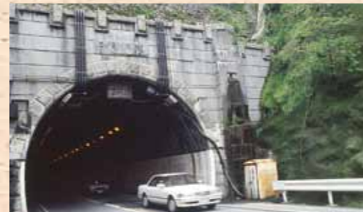
写真2=日見トンネル
