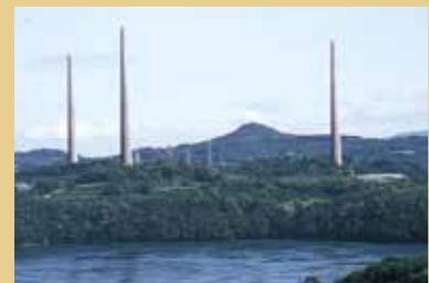
▲針尾無線送信塔(国指定重要有形文化財)
