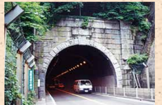
写真3=戸町トンネル(昭和8年(1933)完成)
