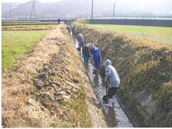
水路の土砂上げ
