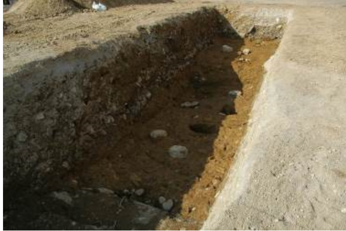
基礎杭検出状況（南から）
