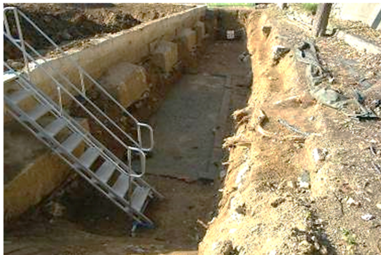
s レンガ造構造物検出状況（北から）
