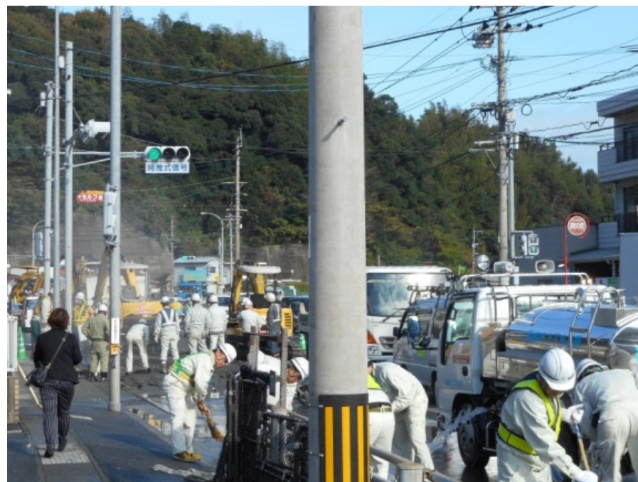
水道管破損事故復旧状況
