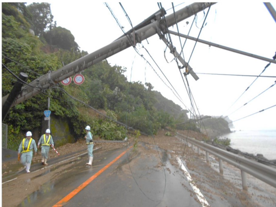
大雨による被災状況
