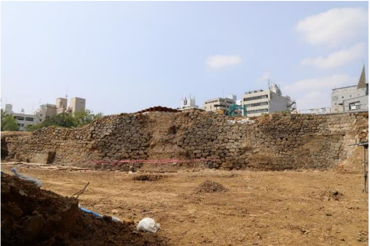
<③ 真横からみた石垣の全景 南から>
