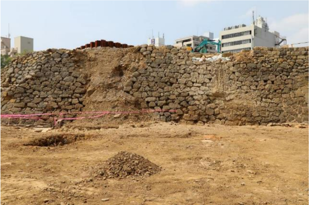
<⑤ 石垣（中央部分） 南から>
