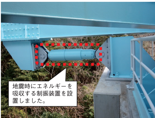
〈主要地方道平戸生月線 平戸市 生月大橋〉
