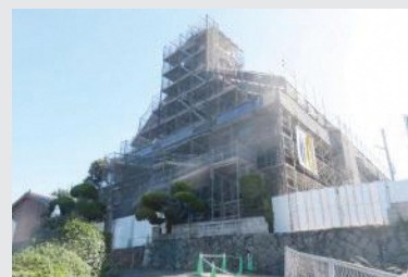
修復工事中の黒島天主堂(佐世保市)
