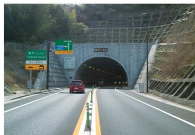
写真上:西海橋と新西海橋 写真中:小迎IC付近 写真下:指方トンネル
