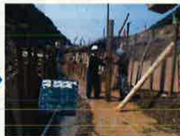
②親杭を打ち込みます。
