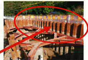
道路に近接しているため、鋼矢板で仮設土留工を行う。(※上記はイメージです)
