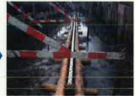
④親杭梯子胴木が完成しました。
