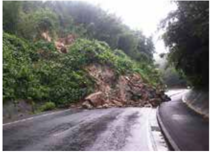
令和2年度7月豪雨により被災した勝本石田線(苓崎市芦辺町)
