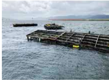
令和2年台風10号により被災した長崎空港連絡船棧橋施設(大村市箕島町)
