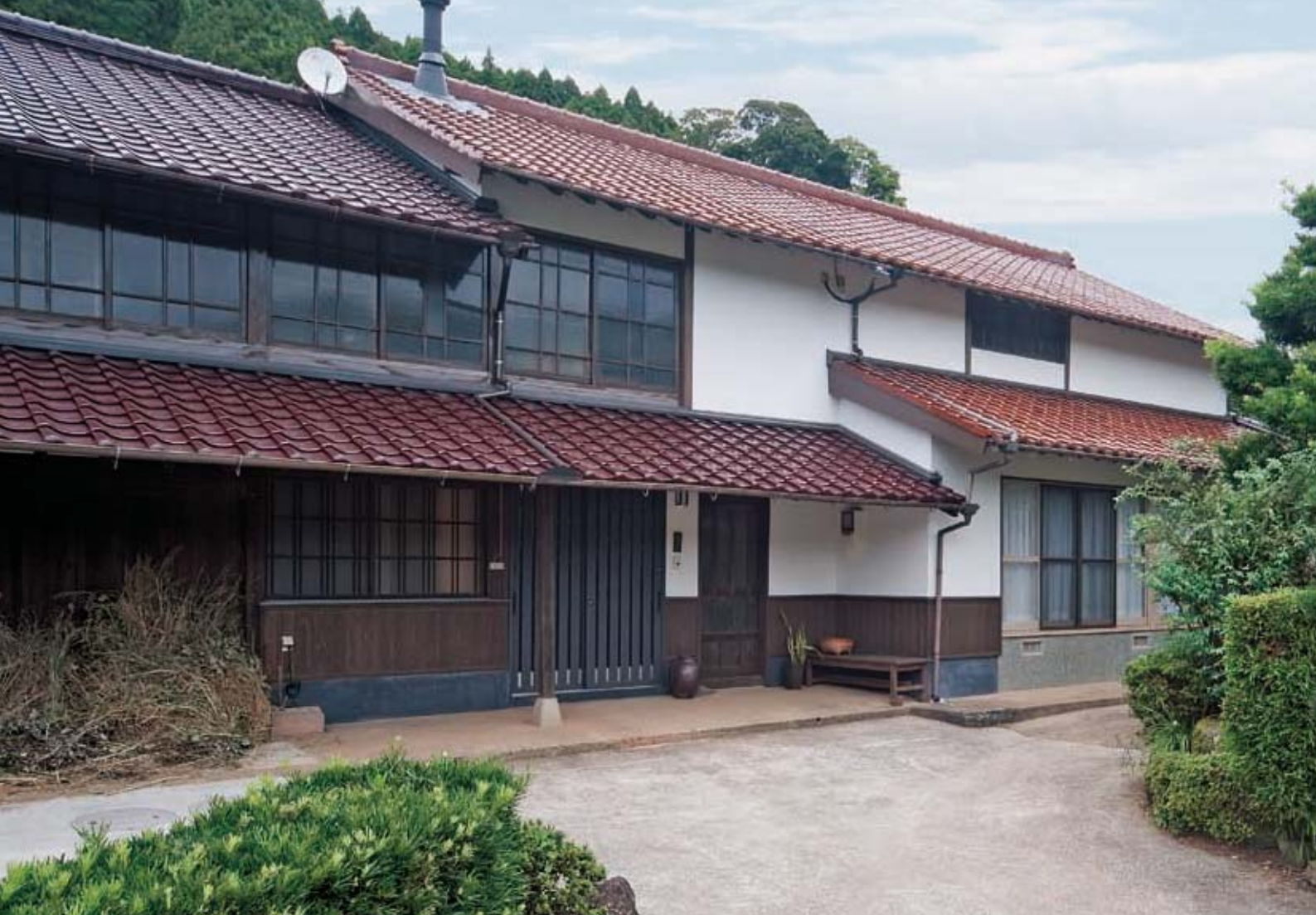
[屋根・外観] 改修後
