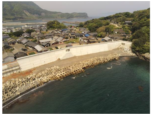
海岸保全施設整備（簿山地区）
