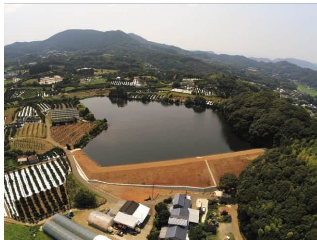
改修された農業用ため池（佐世保地区 六郎ため池）
