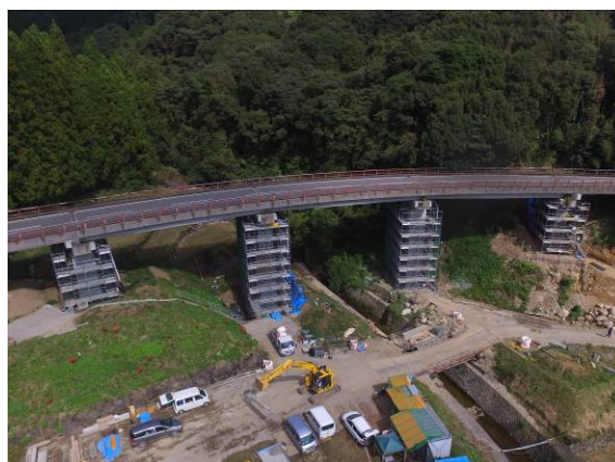
橋梁の耐震対策実施状況 （大村レインボーロード地区）
