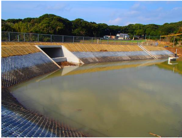
ため池整備（郷ノ浦地区 泉ヶ山ため池）
