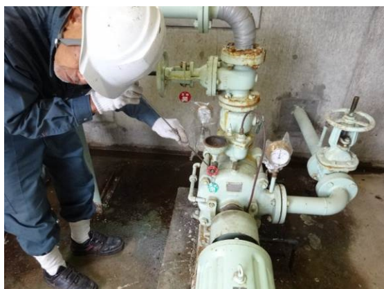
ポンプ設備の機能診断状況
