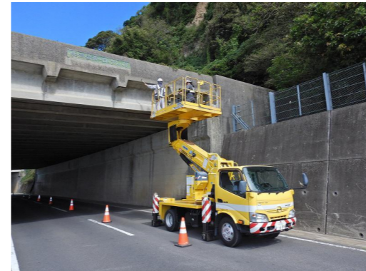
ロックシェッド 点検状況
