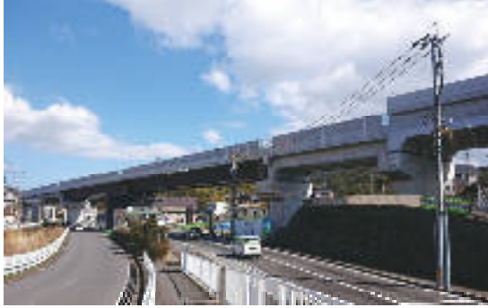
諫早市 宇都橋りょう(R3.2撮影)
