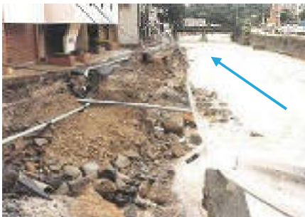
長崎大水害（S57.7.23）の被災状況
