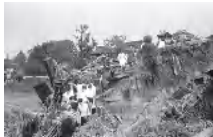
諫早大水害（S32.7.25）の被災状況
