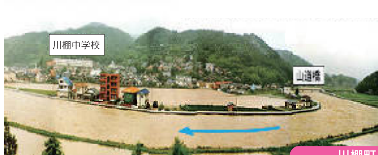
平成2年水害（H2.7.2）の被災状況
