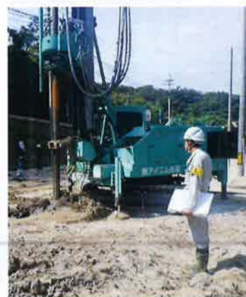
深層混合処理工法 施工状況
