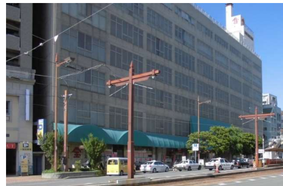
法定耐用年限を超過し老朽化した建物
