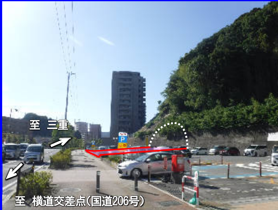
起 点 (県道長崎畝刈線との接続部)
