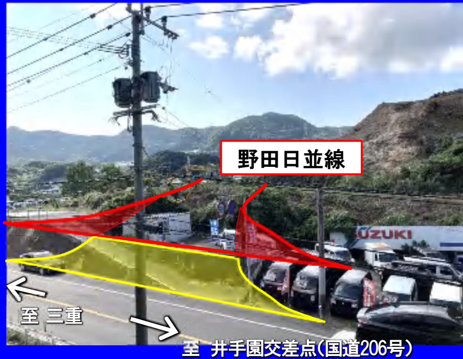
(起点部) 臨港道路との接続部
