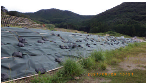
防草シート設置状況（令和3年9月撮影）
