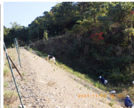
抜き取り作業状況（令和3年11月撮影）
