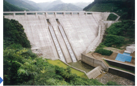
萱瀬ダムかさ上げ後（平成12年6月撮影）
