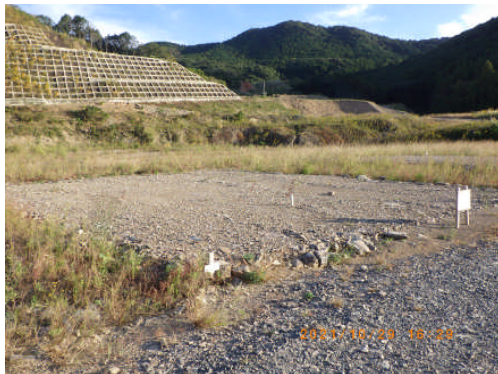
50cmの覆土を行った後、約90日後の状況（令和3年10月撮影）
