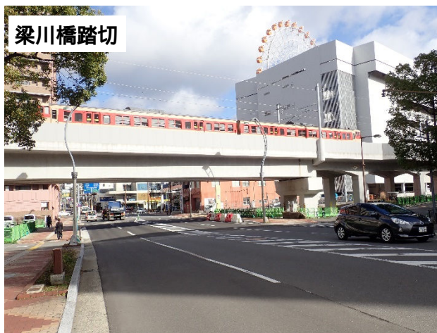
梁川橋踏切の高架状況
