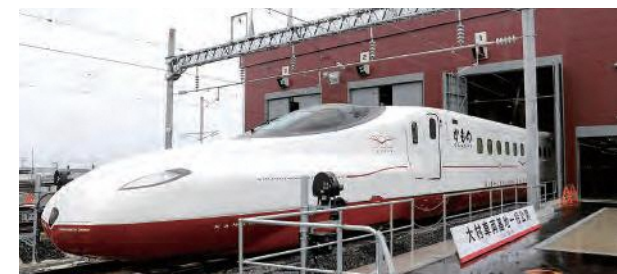
西九州新幹線大村車両基地
