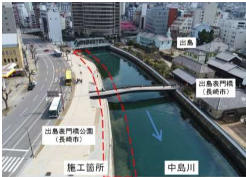
(工事箇所全景)
