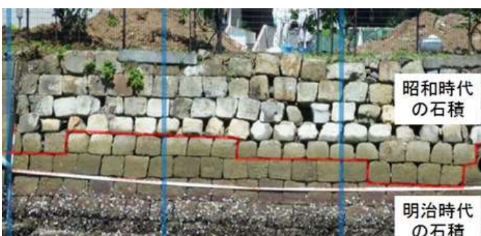
(改修前の石積護岸状況)
