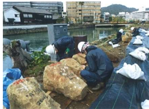
(遺構調査状況)
