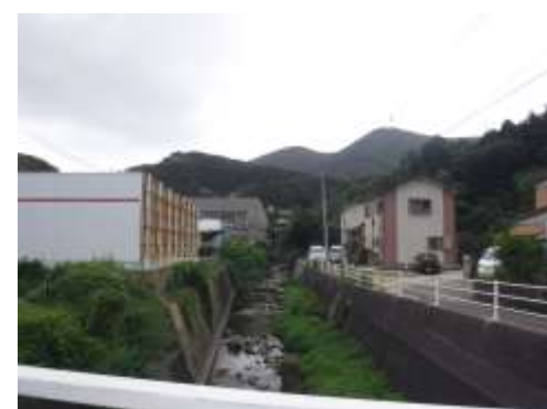
事前放流開始後下流河川状況
