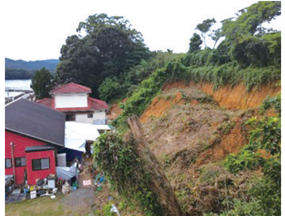
人家隣接の斜面が崩落（令和3年 西海市）
