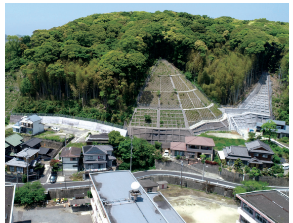
斜面下部の多くの人家を保全している法面工(佐世保市 陣の内(2)地区)
