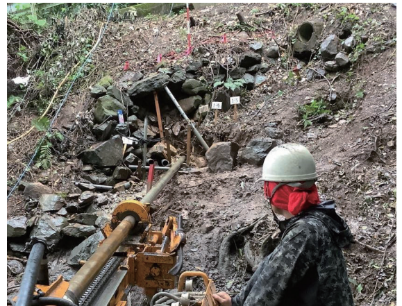
地すべりの主な原因である地下水を抜くための工事
