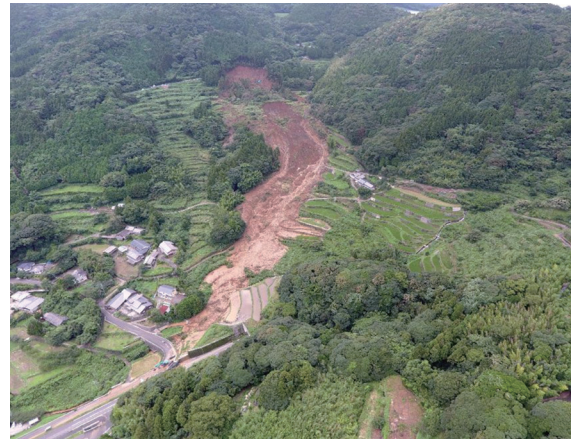
地すべりによる被災状況（令和2年 佐世保市牧の地地区）
