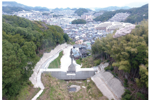
人家、道路を保全している砂防堰堤(長崎市)
