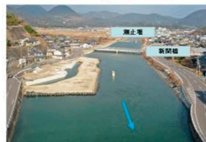
江ノ浦川（諫早市）における河川改修工事
