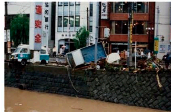
西浜の町電停付近の被災（長崎市）
