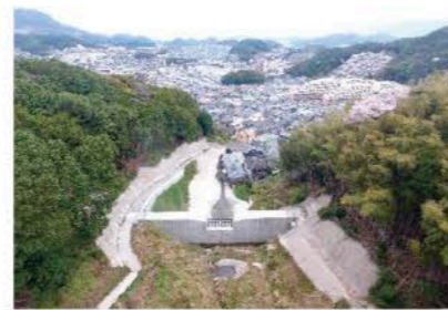
土石流対策の砂防ダム（長崎市）
