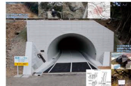
工事名 主要地方道蔵原豆蔵美津島線道路改良工事(仮称)尾浦トンネル 施工業者 小宮・東邦特定建設工事共同企業体 技術者 平間 源一
