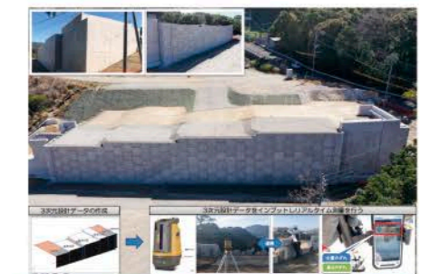
工事名 主要地方道長崎南環状線道路改良工事(大山町1工区) 施工業者 錦建設工業(株) 技術者 柿田 茂則
