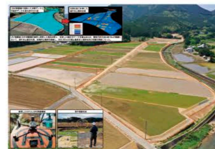
工事名 寺脇地区区画整理工事(8・9工区) 施工業者 (株) 橋本組 技術者 橋本 権生
