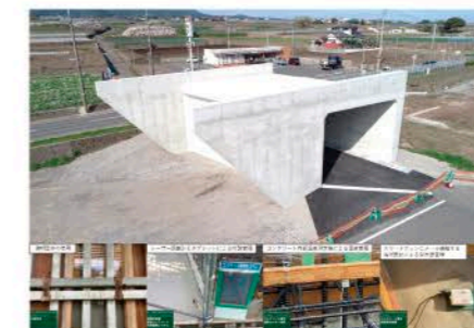
工事名 一般国道251号道路改良工事(原口町3号雨渠) 施工業者 (株) 吉川組 技術者 出口 明義
