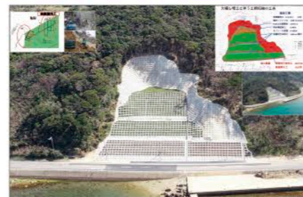
工事名 一般県道青方港魚目線道路災害復旧工事(1工区) 施工業者 (株) 親和テクノ 技術者 大瀬良 祐史
