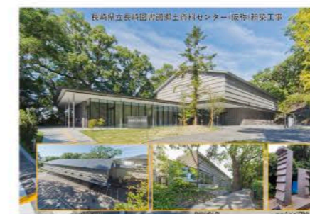
工事名 長崎県立長崎図書館郷土資料センター(仮称)新築工事 施工業者 上滝・三基・長崎大建特定建設工事共同企業体 技術者 田中 久士
