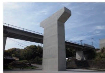
工事名 一般国道251号道路改良工事(4号橋P1) 施工業者 鳥田組(株) 技術者 松本 俊一
