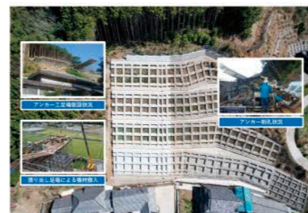
工事名 多良地区急傾斜地崩壊対策工事 施工業者 大栄開発(株) 技術者 木島 良一
