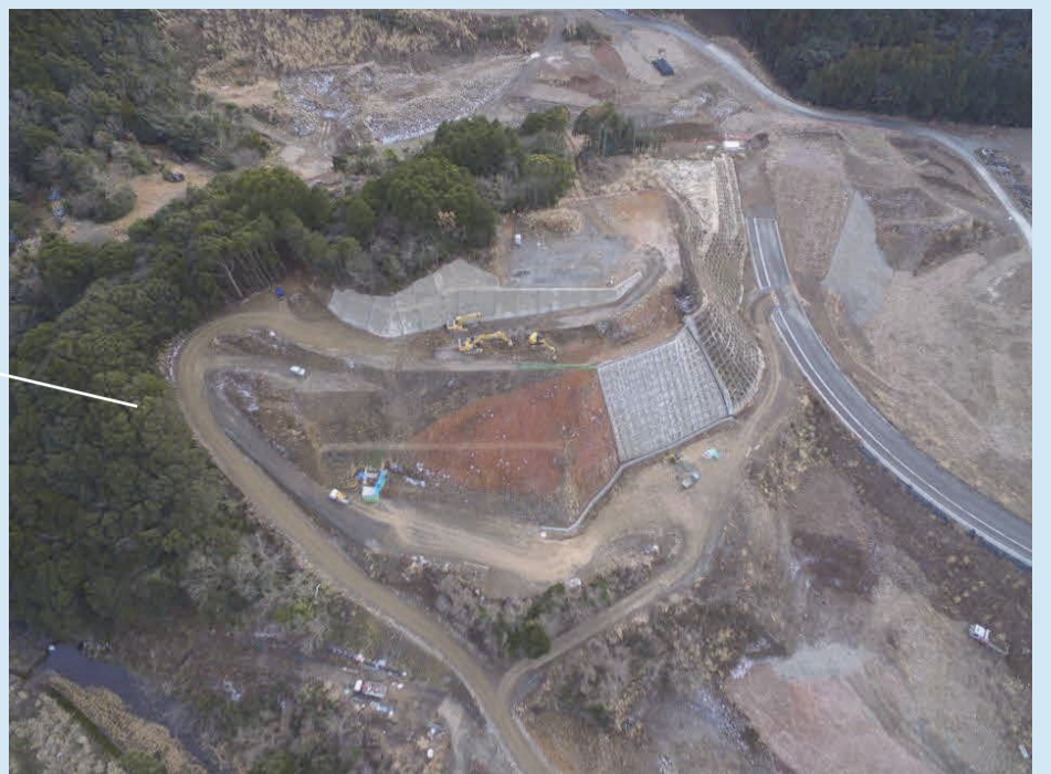
ダム本体にかかる左岸掘削工事(令和5年1月撮影)
