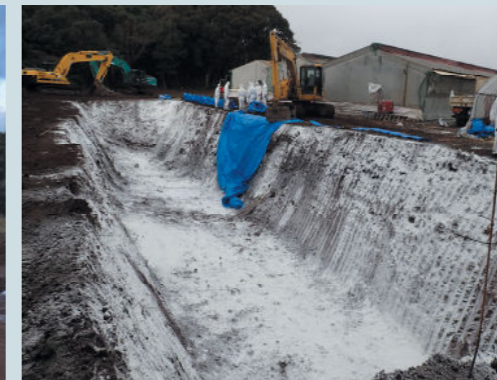
埋却地掘削後
