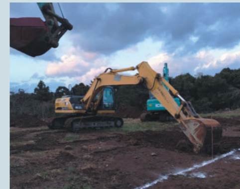
殺処分した鶏の埋却地の掘削作業
