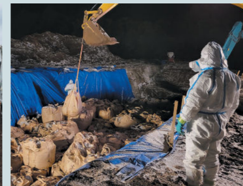
埋却地への積み下ろし
