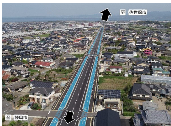
自転車道の整備（一般県道大村外環状線）
