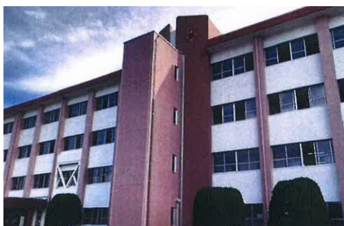
佐世保商業高校エレベーター棟増築等工事
