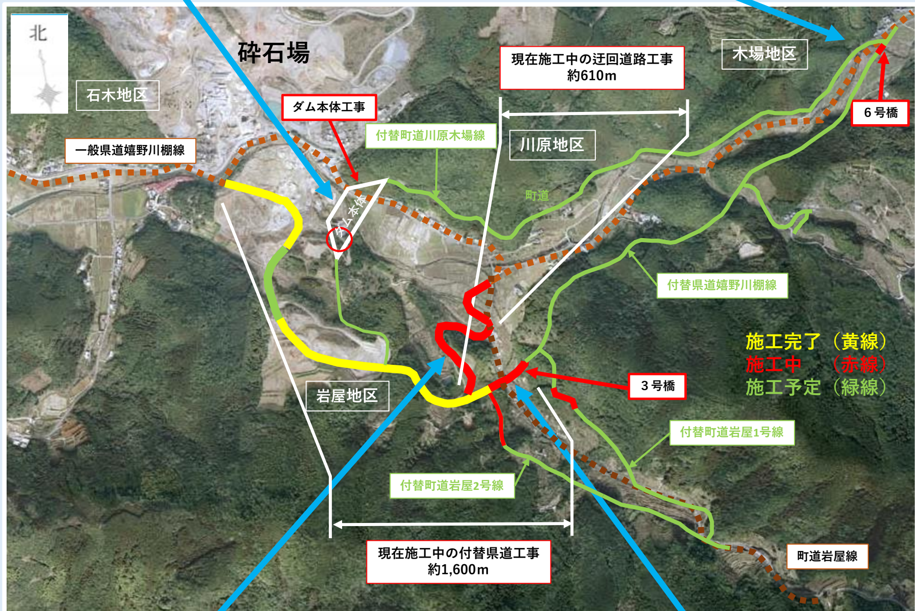
迂回路工事の施工状況
