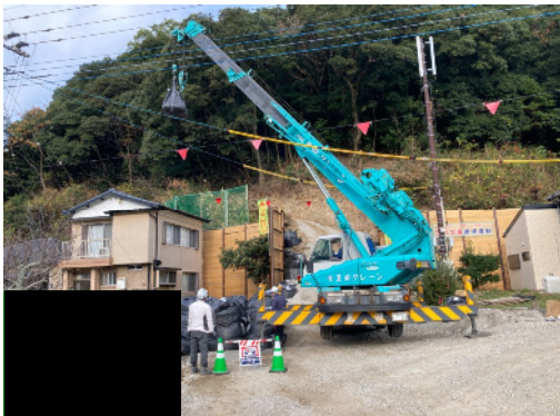
大型土のう設置 (クレーン設置状況)
