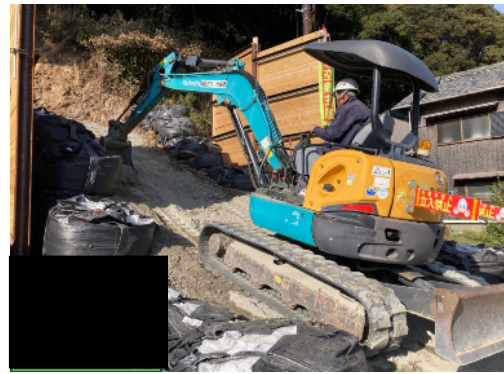
地盤改良 (固化剤攪拌状況)
