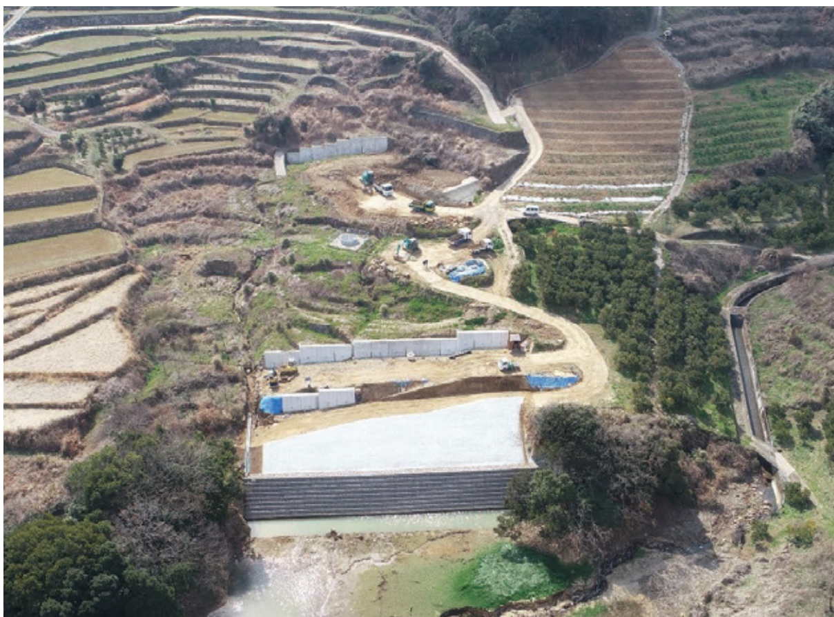
座木地区の抑止工（南島原市）
