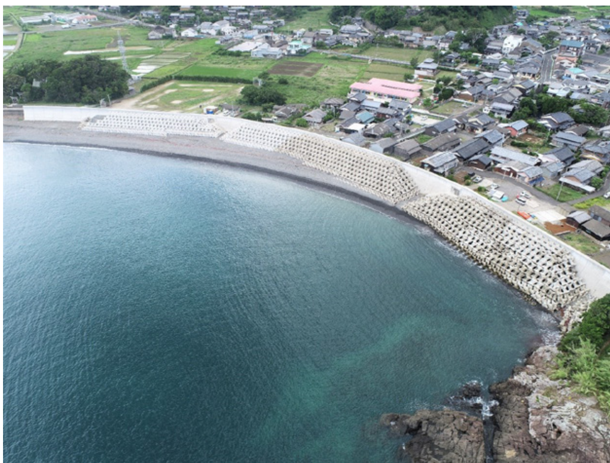
簿山地区の堤防工 (平戸市)
