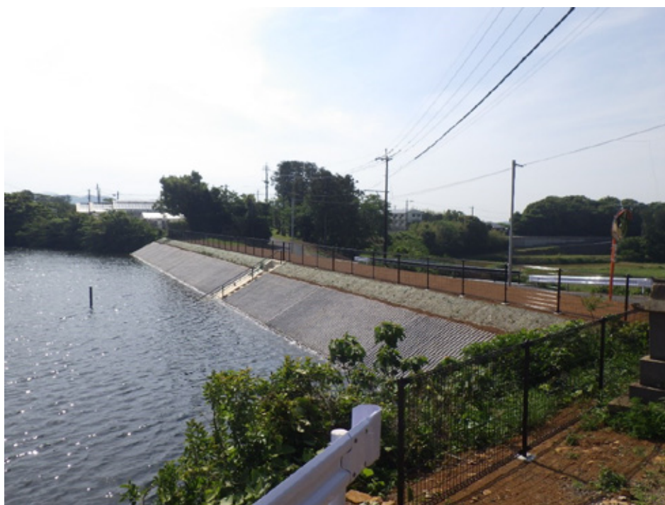
平戸2期地区 鴨山ため池 (平戸市)
