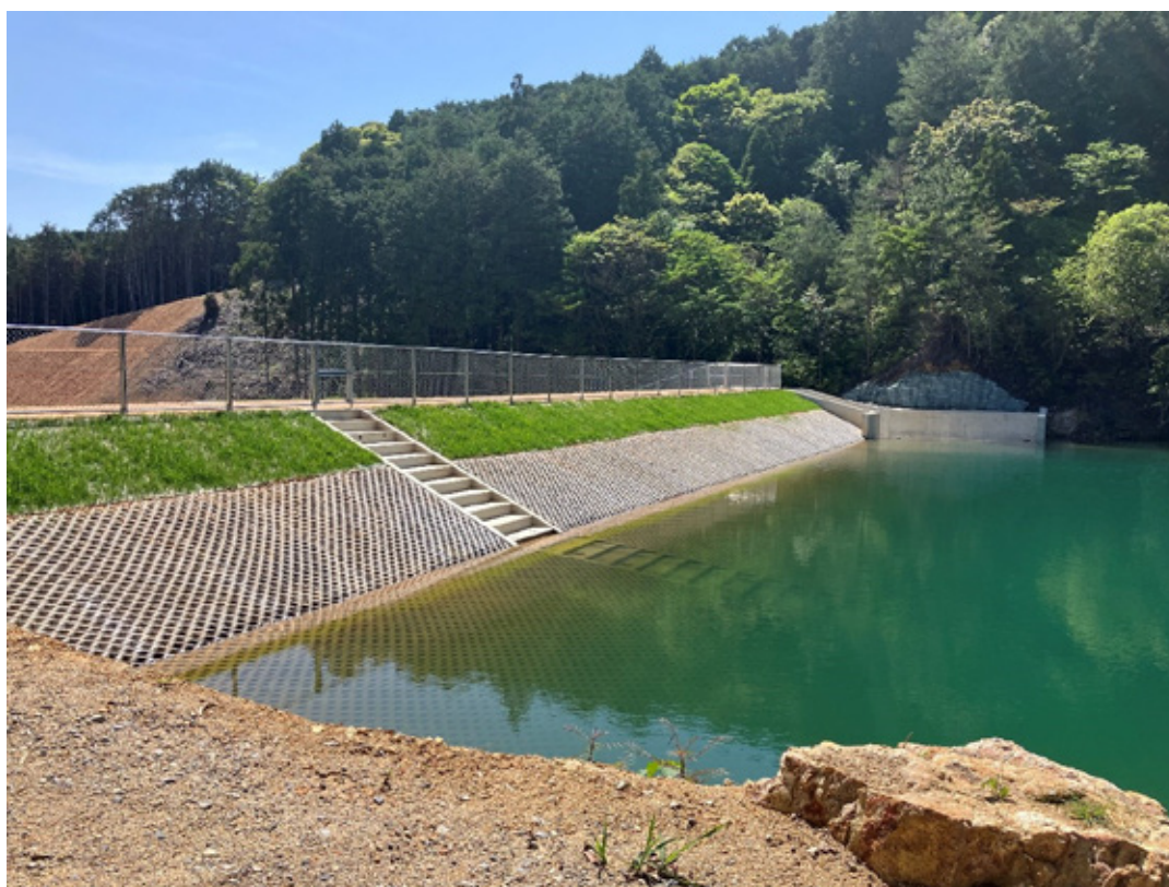
五島地区 津木ため池（五島市）
