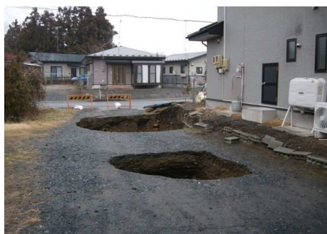
写 3-3 宅地地盤の陥没の例
