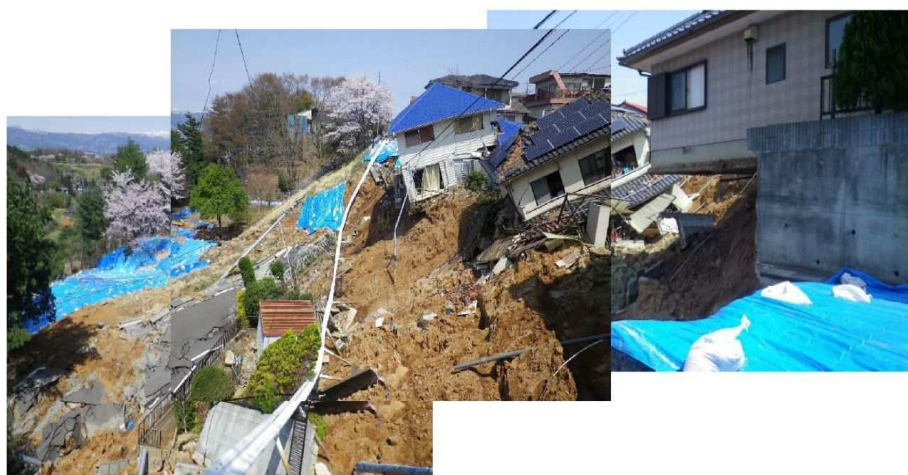
写 3-11 のり面の崩壊の例
