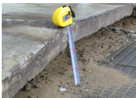
写 3-5 宅地地盤の段差の例
