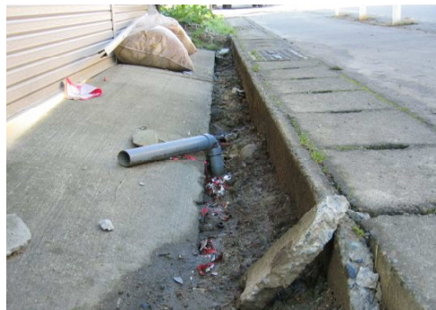
写 3-5 宅地地盤の段差の例
