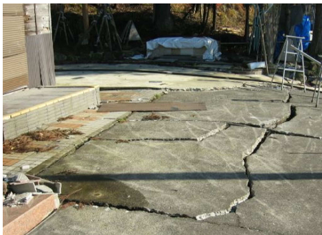
写3-2 宅地地盤のクラックの例
