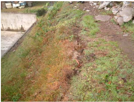
写3-8 のり面のクラックの例
