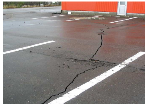
写3-2 宅地地盤のクラックの例
