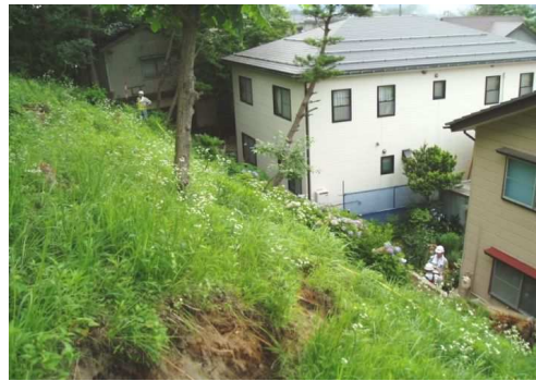
写3-8 のり面のクラックの例
