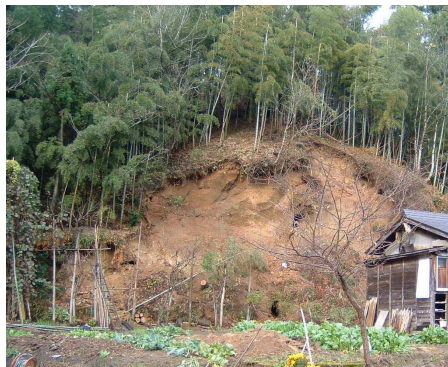
写 3-10 のり面のガリー浸食の例
