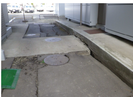
写 3-4 宅地地盤の沈下の例
