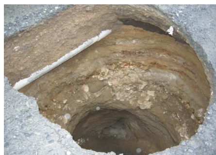
写 3-3 宅地地盤の陥没の例
