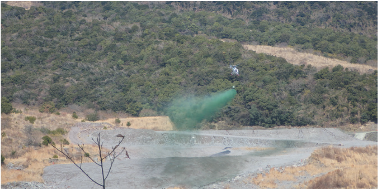
雲仙・普賢岳 水無川流域（航空実播工 こうくうじっばんこう 施工状況 令和3年2月）
