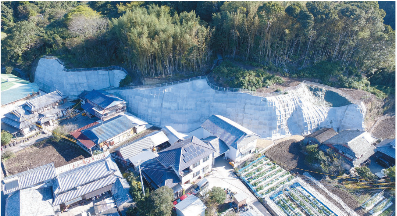
田平地区緊急予防治山工事 完成全景
