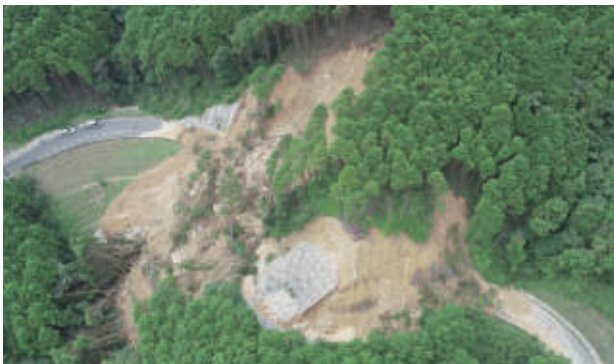
林道の被災状況確認(新上五島町)
