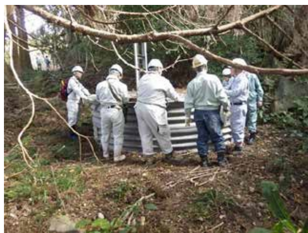
施設点検の様子
