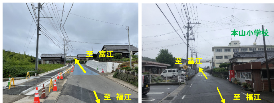
一部整備中区間
