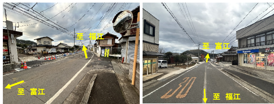
工事状況写真
